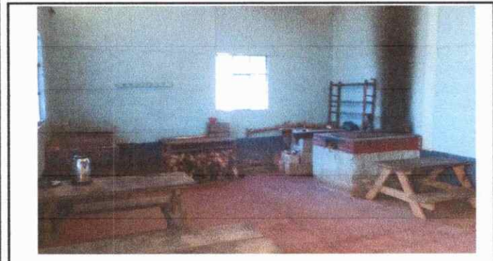
Foto 3: Instalación de piso ceramico en cocina
