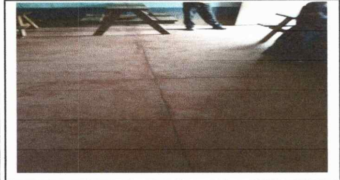
Foto 1: Sustitución de piso a piso ceramico, aulas
