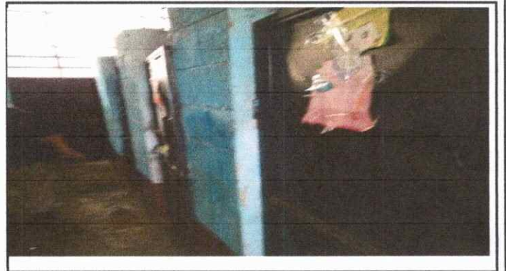
Foto 8: Rehabilitación de Pared de baños
